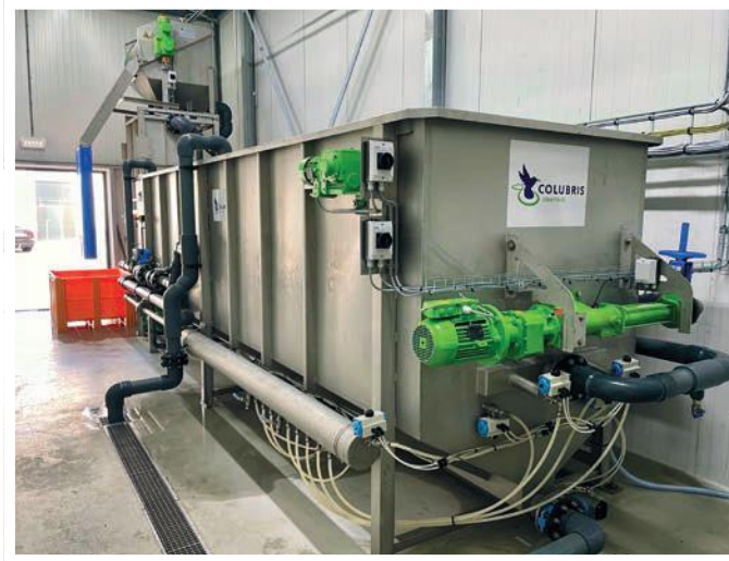
↑ → De zuivering van de Plukon vestiging in Nijkerk, bestaande uit trommelfilter, aanmaakunit voor polymeer en een DAF unit (Dissolved Air Flotation).
