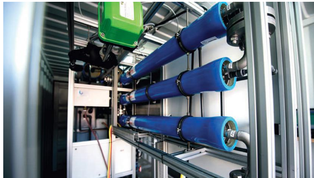
↑ De brine-concentrator-pilot met meertraps nanofiltratiesysteem tot 80 bar.
