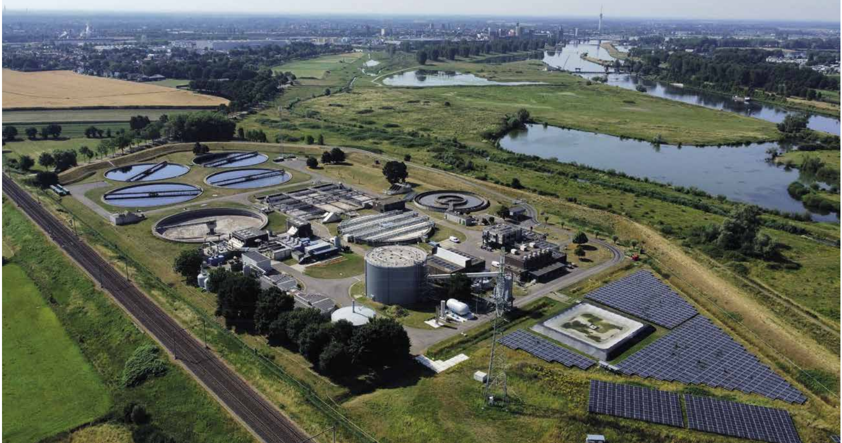
De rioolwaterzuivering in Roermond van Waterschap Limburg.
