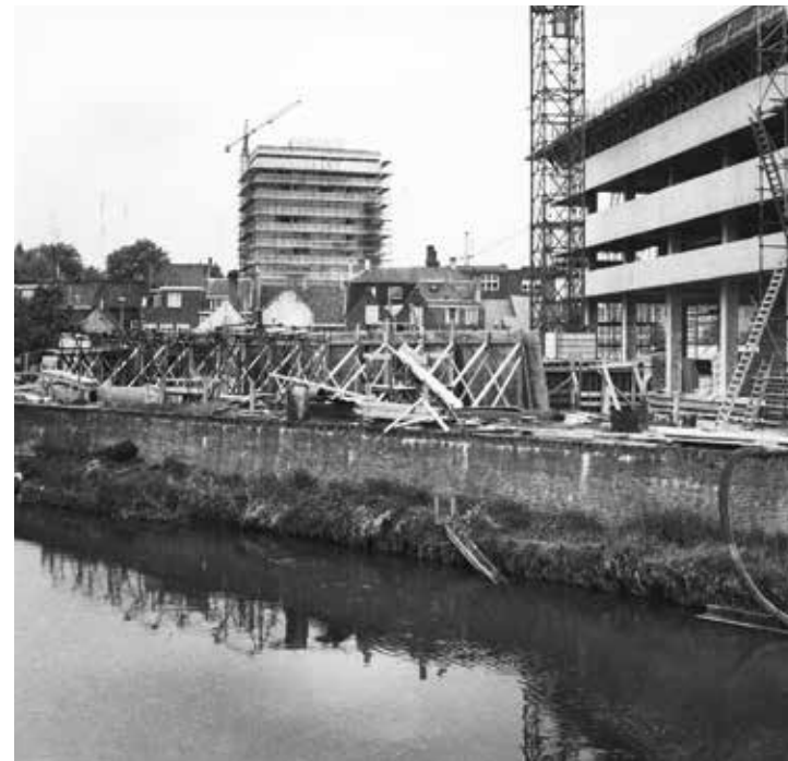
▲ Het DELA-gebouw in aanbouw aan de Dommel, Eindhoven, 1972.
