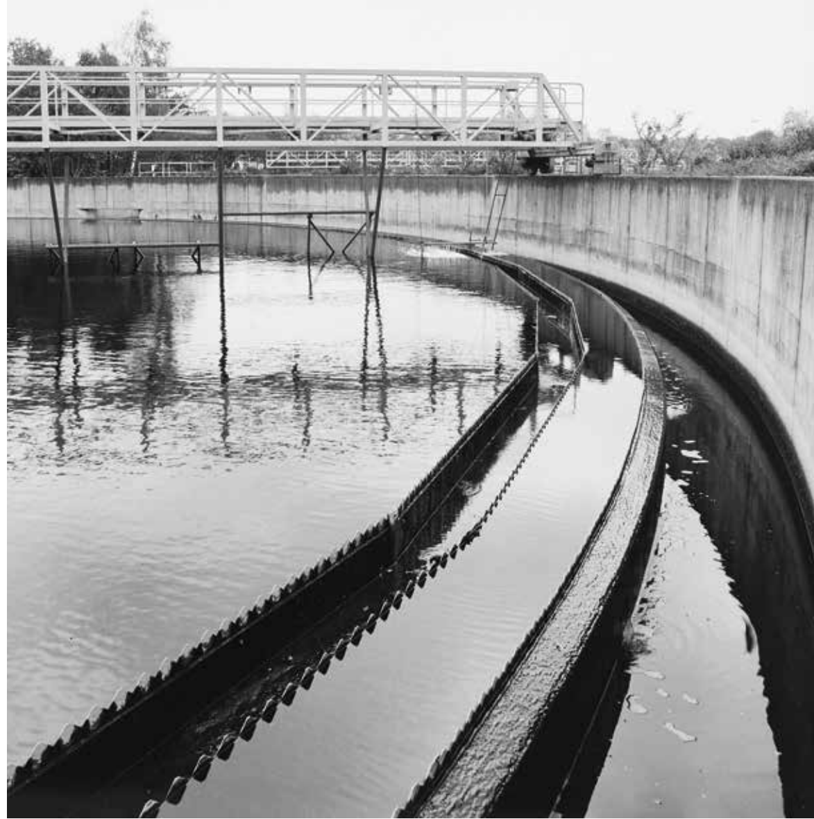
► Waterzuivering aan de Dommel in Eindhoven, stadsdeel Tongelre.
